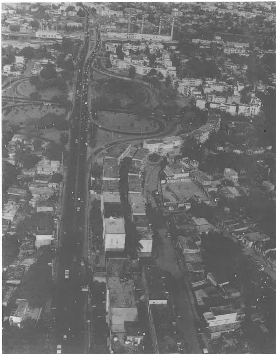
La Avenida "26 de Enero", que enlaza Villa Duarte con la parte occidental de Santo Domingo, pasando sobre los puentes gemelos "Francisco del Rosario Sánchez"
