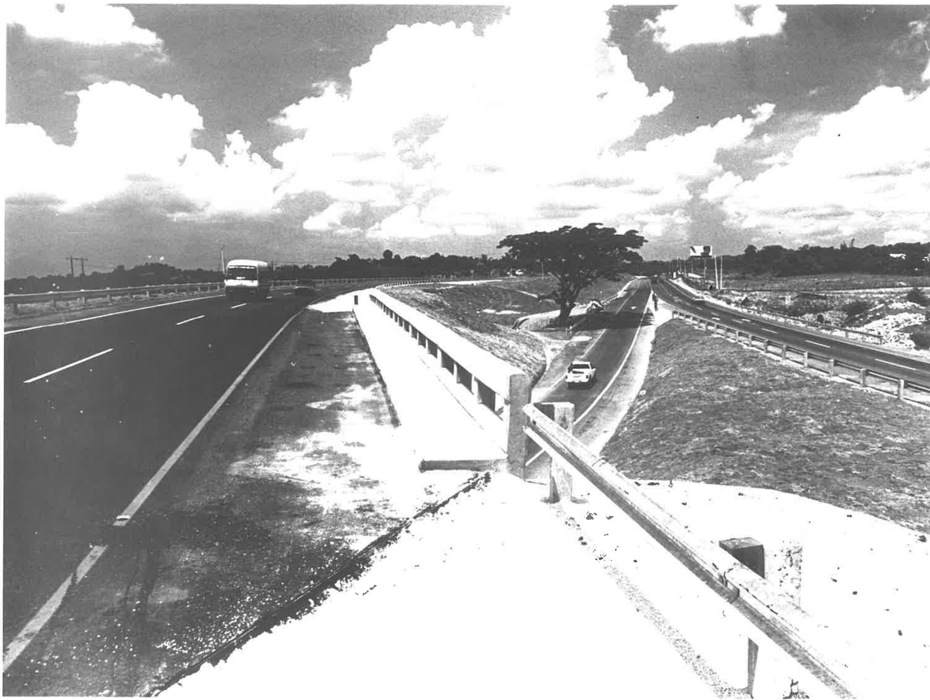
Puente sobre la Autopista Santiago-Santo Domingo a la salida de la ciudad de Santiago de los Caballeros.
