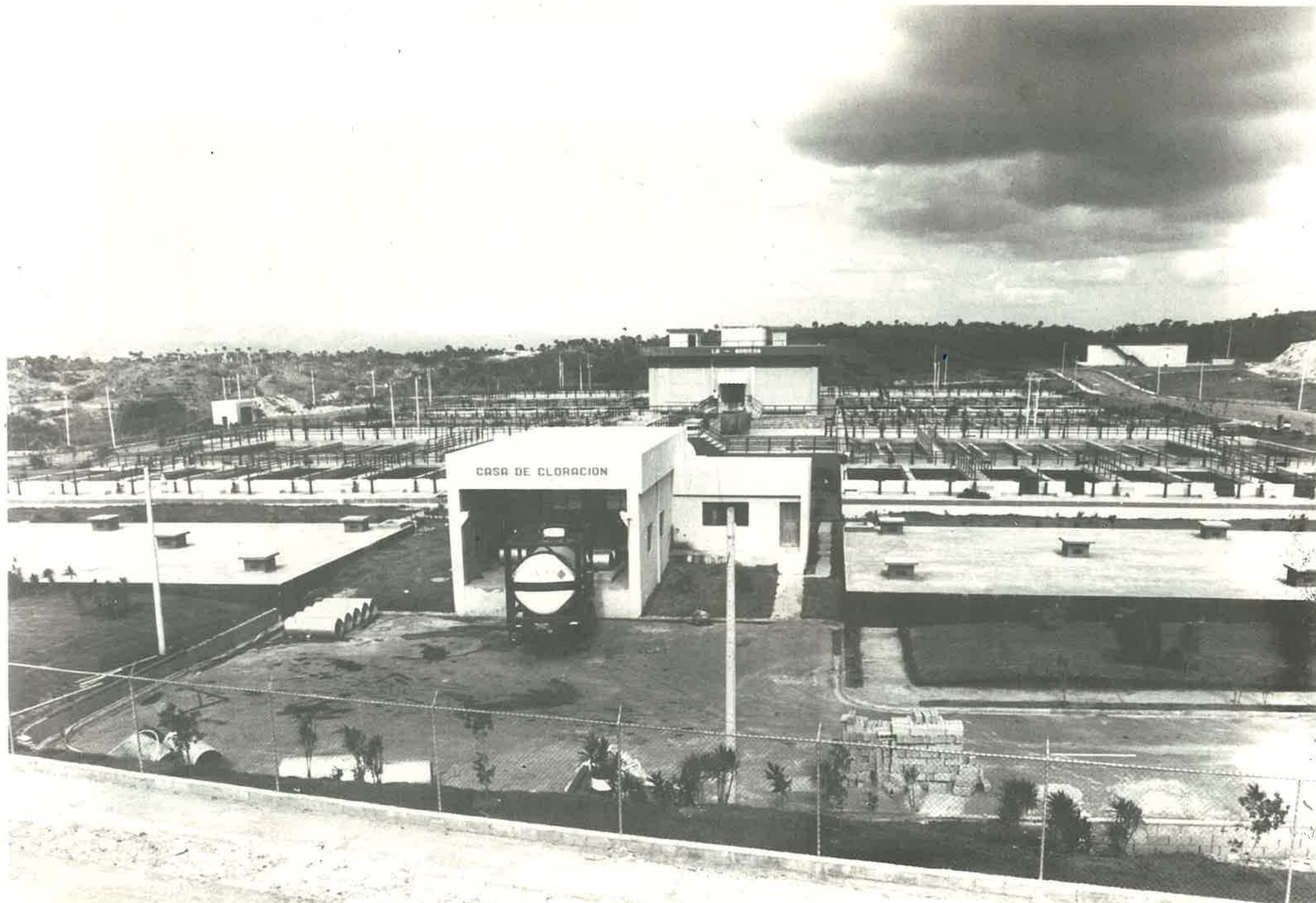
Planta de tratamiento de agua "La Noriega" , Acueducto Central de Santiago , R.D.
