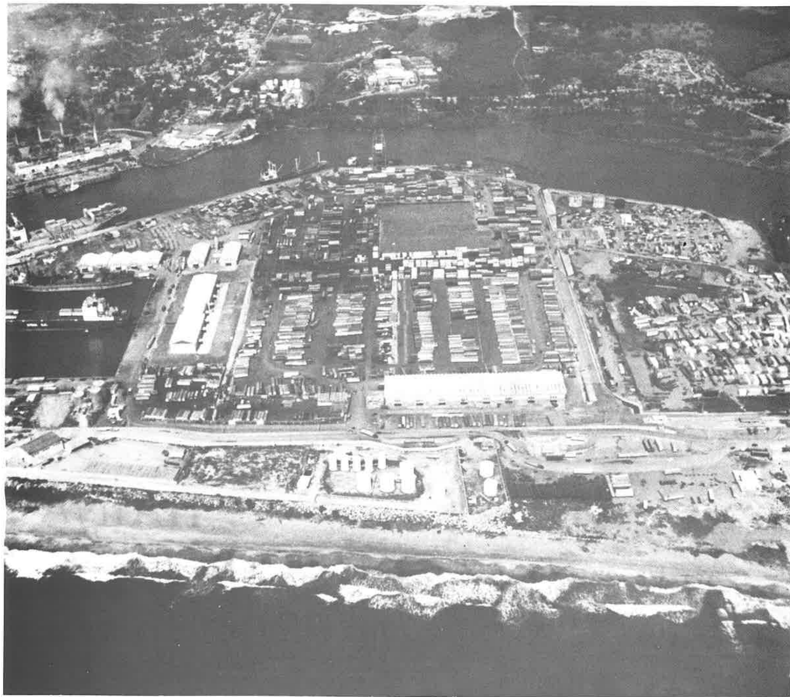
Foto aérea de la ampliación del puerto de Haina.
