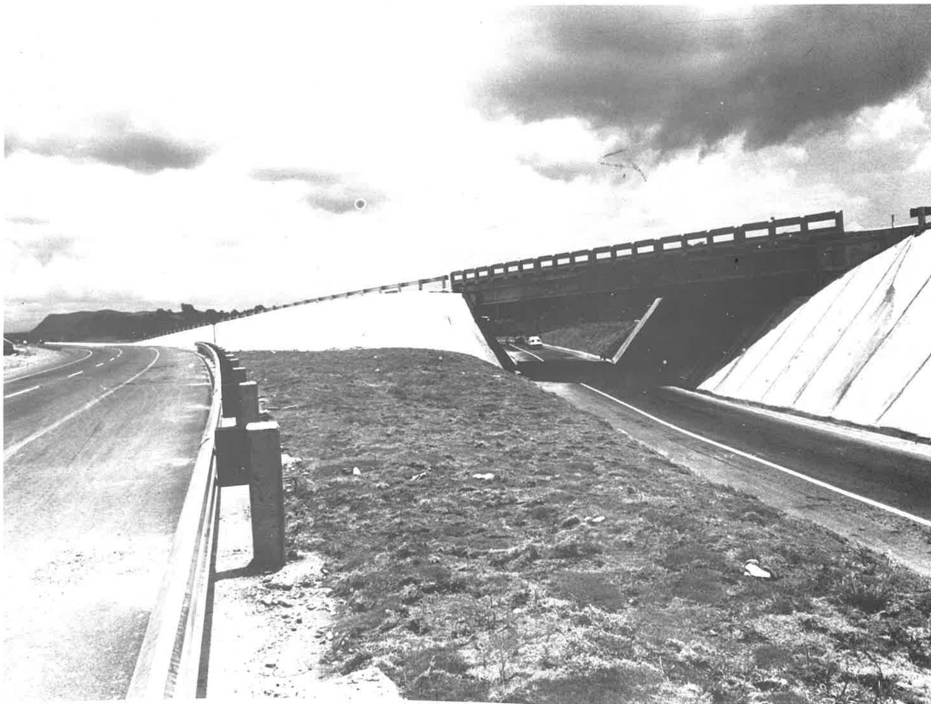
Vista de la moderna autopista a San Cristóbal.
