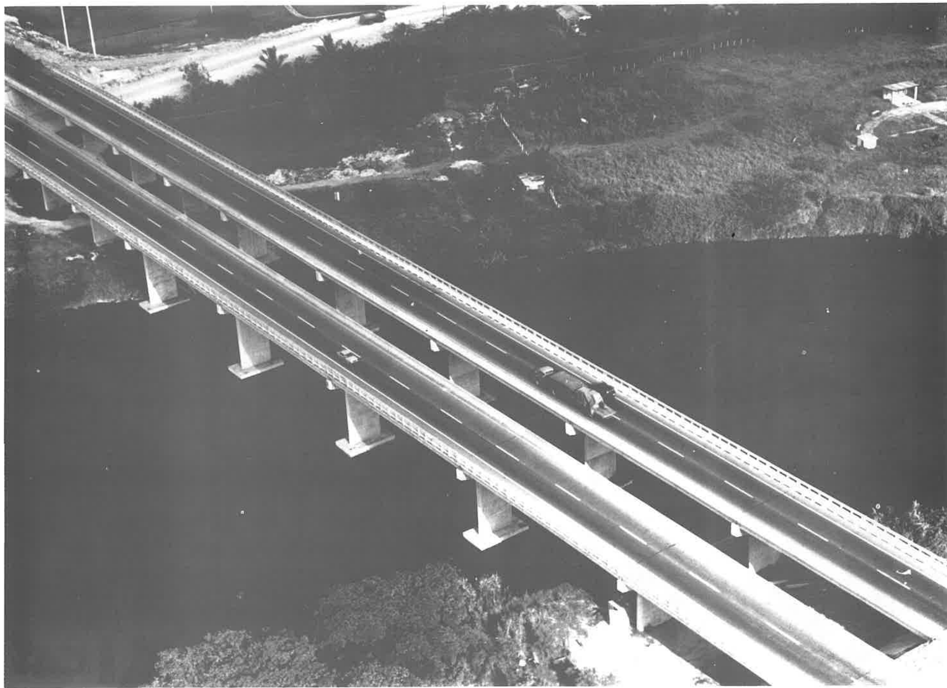
Moderno puente sobre el Río Haina. Autopista a San Cristóbal.
