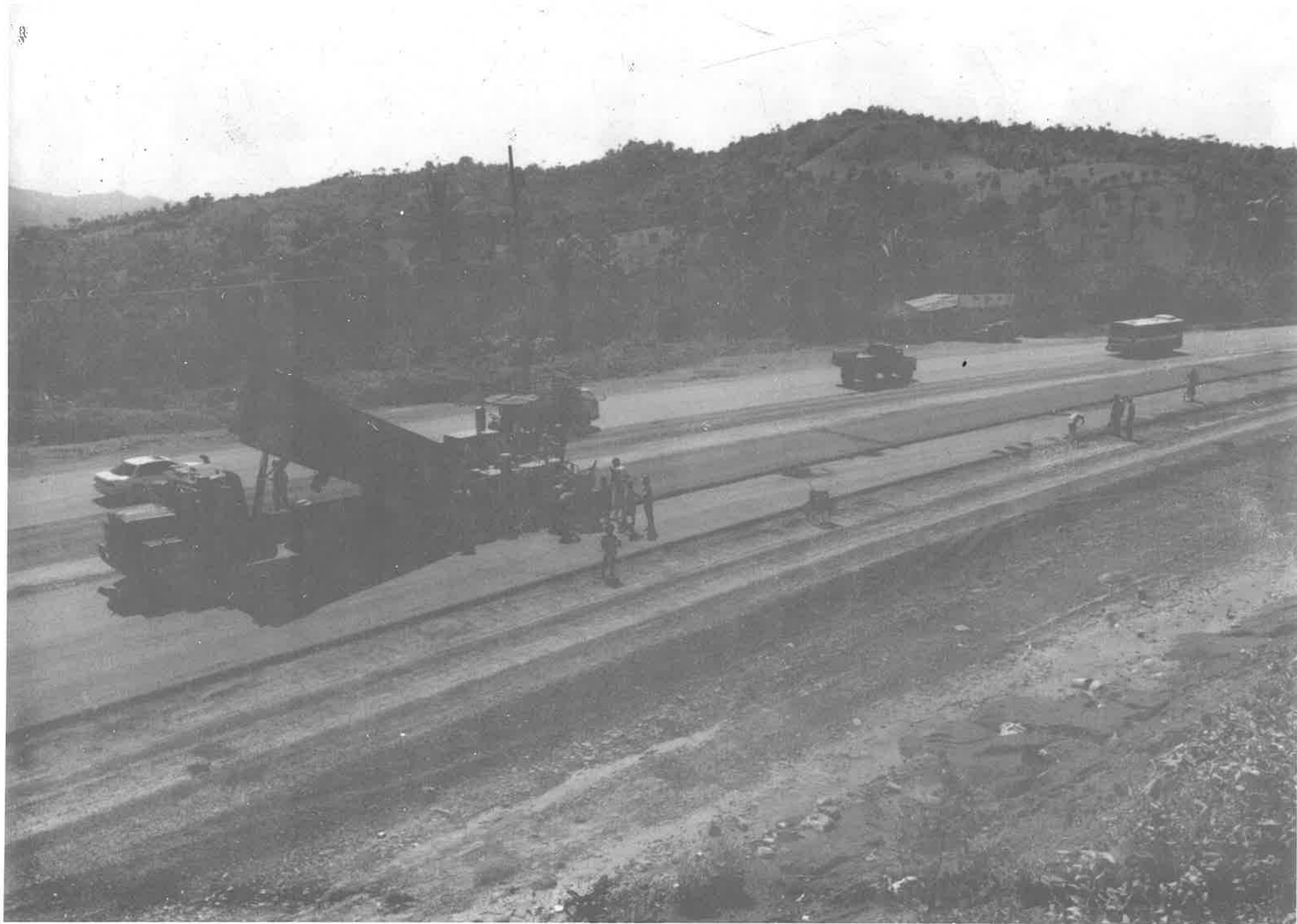
Pavimentación de la Autopista "Duarte", tramo de Santiago de los Caballeros.
