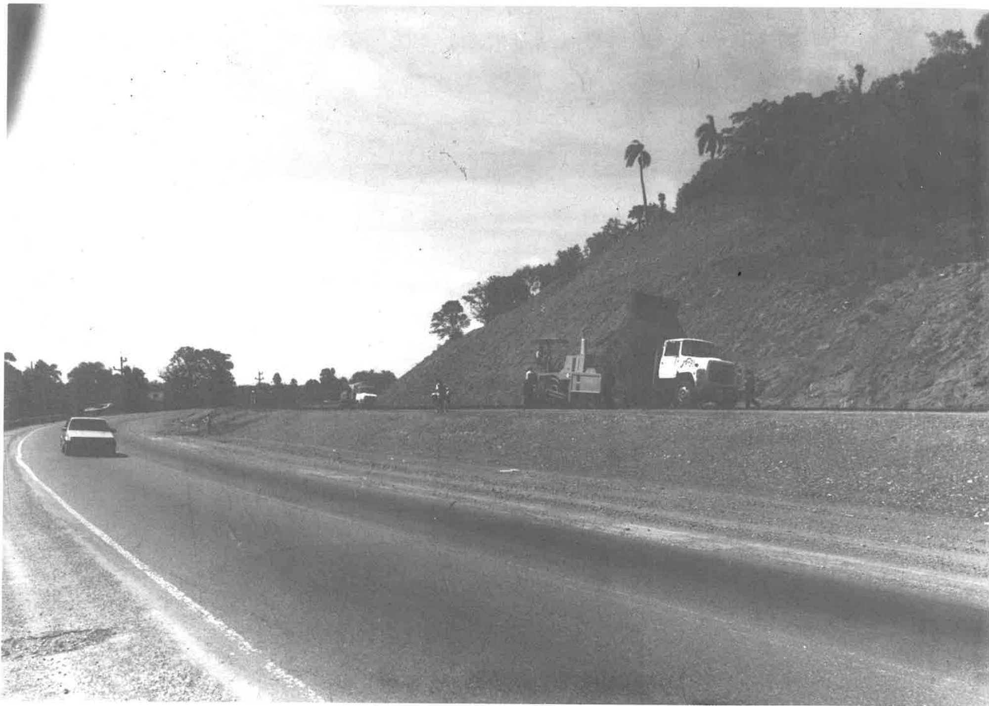
Pavimentación de la Autopista "Duarte"
