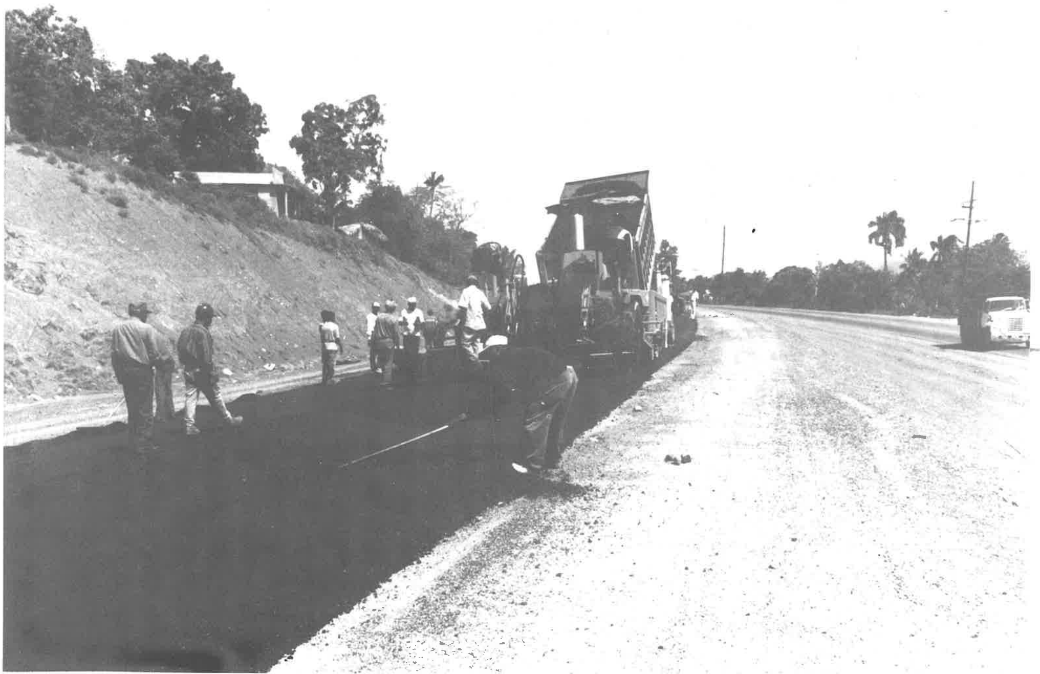
Pavimentación de la Autopista "Duarte", tramo Guaco, La Vega.
