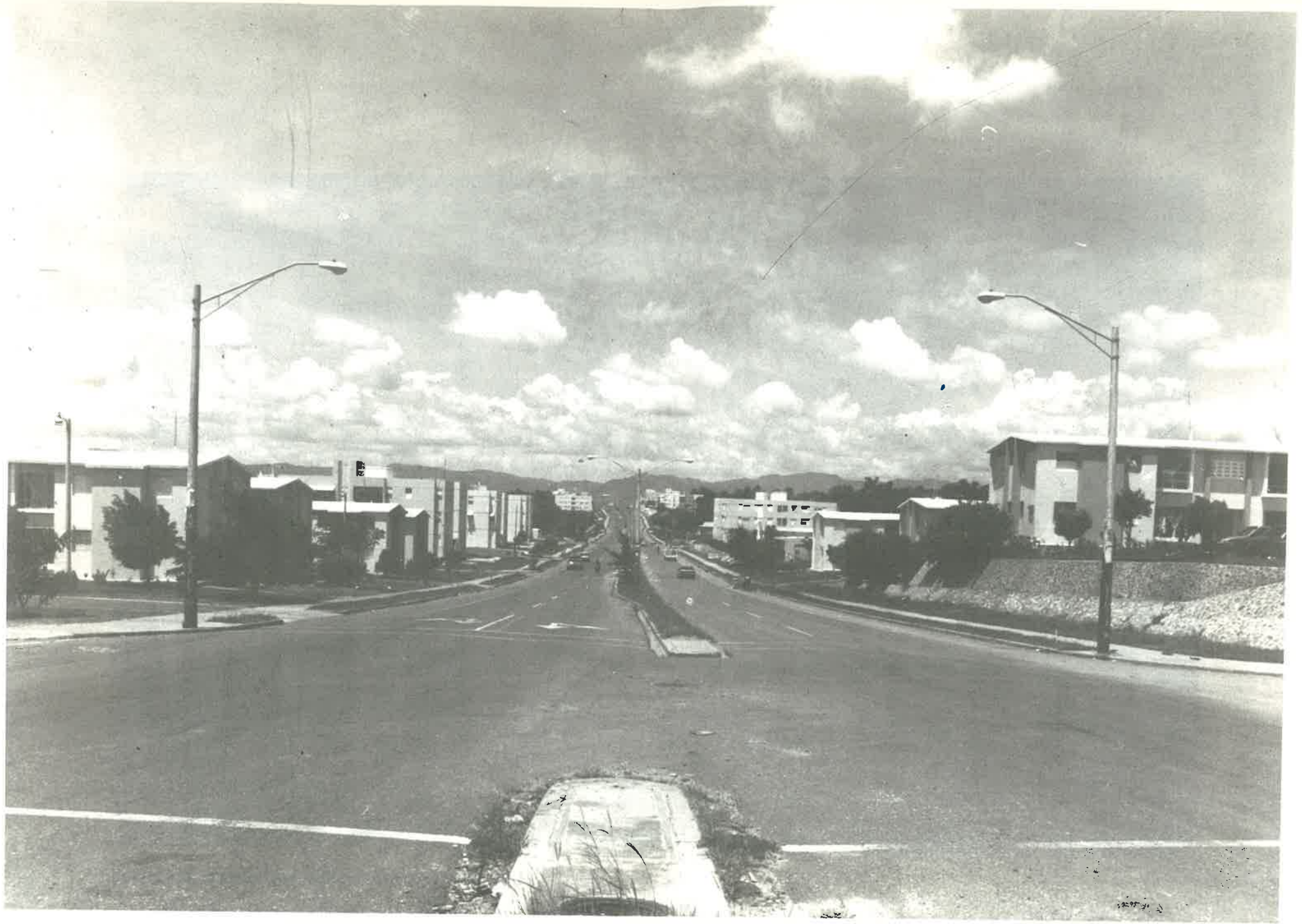
Avenida "Yapur Dumit", Santiago de los Caballeros.
