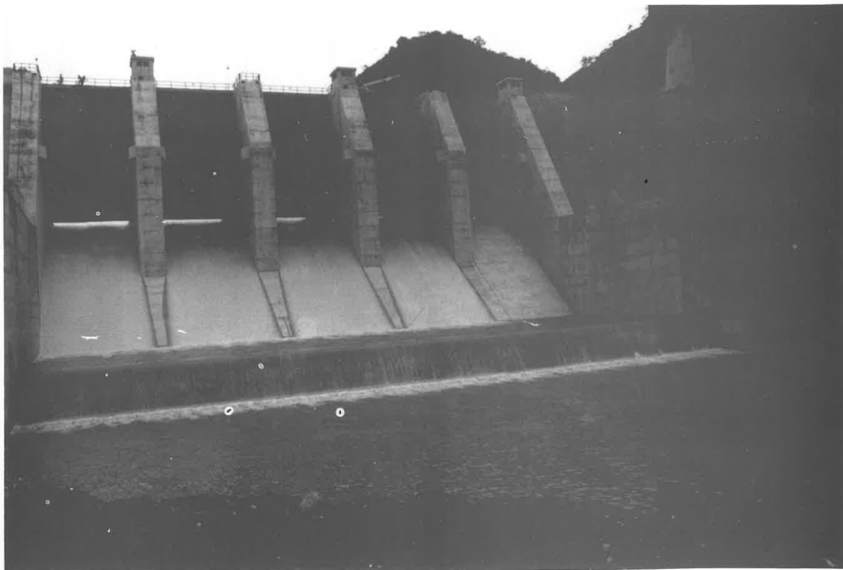
Presa de Jigüey y Aguacate.
