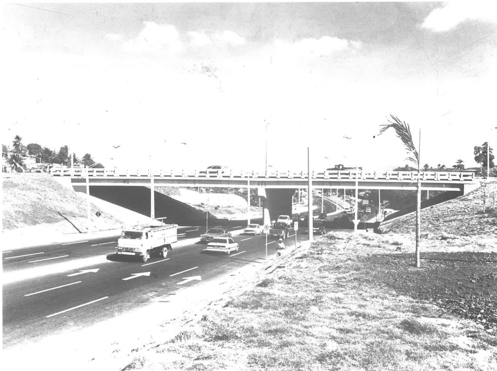
Nuevos puentes en la Autopista Santo Domingo- Santiago
