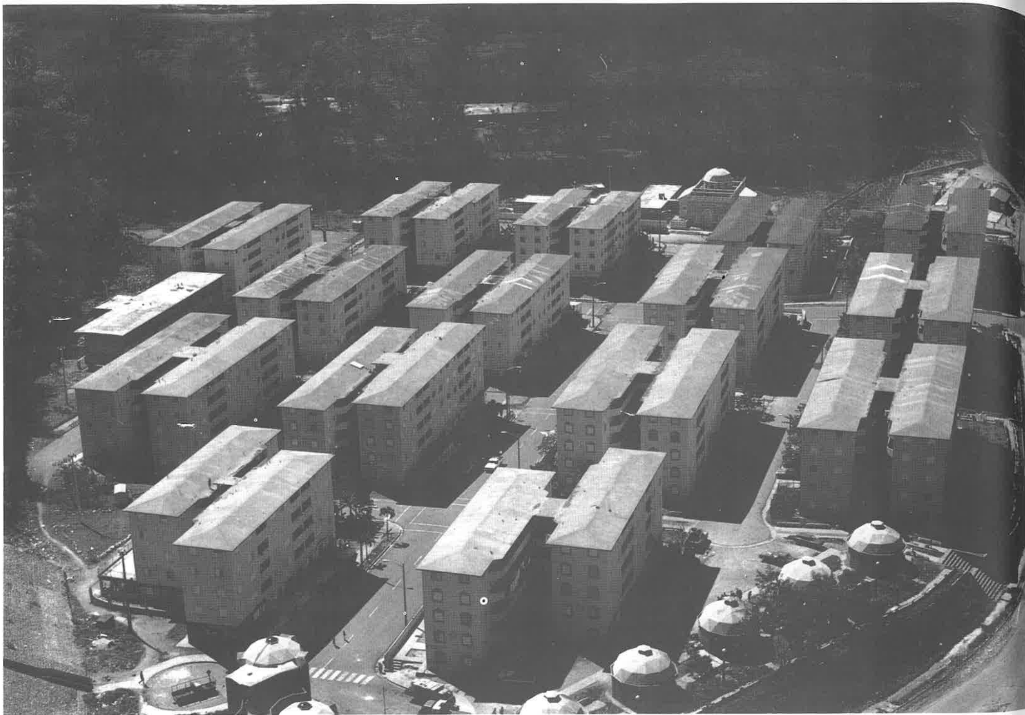
Hermosa vista de "Puerto Isabela", una de las mas importantes obras de recuperación social de una de los barrios mas paupérrimos de Santo Domingo.
