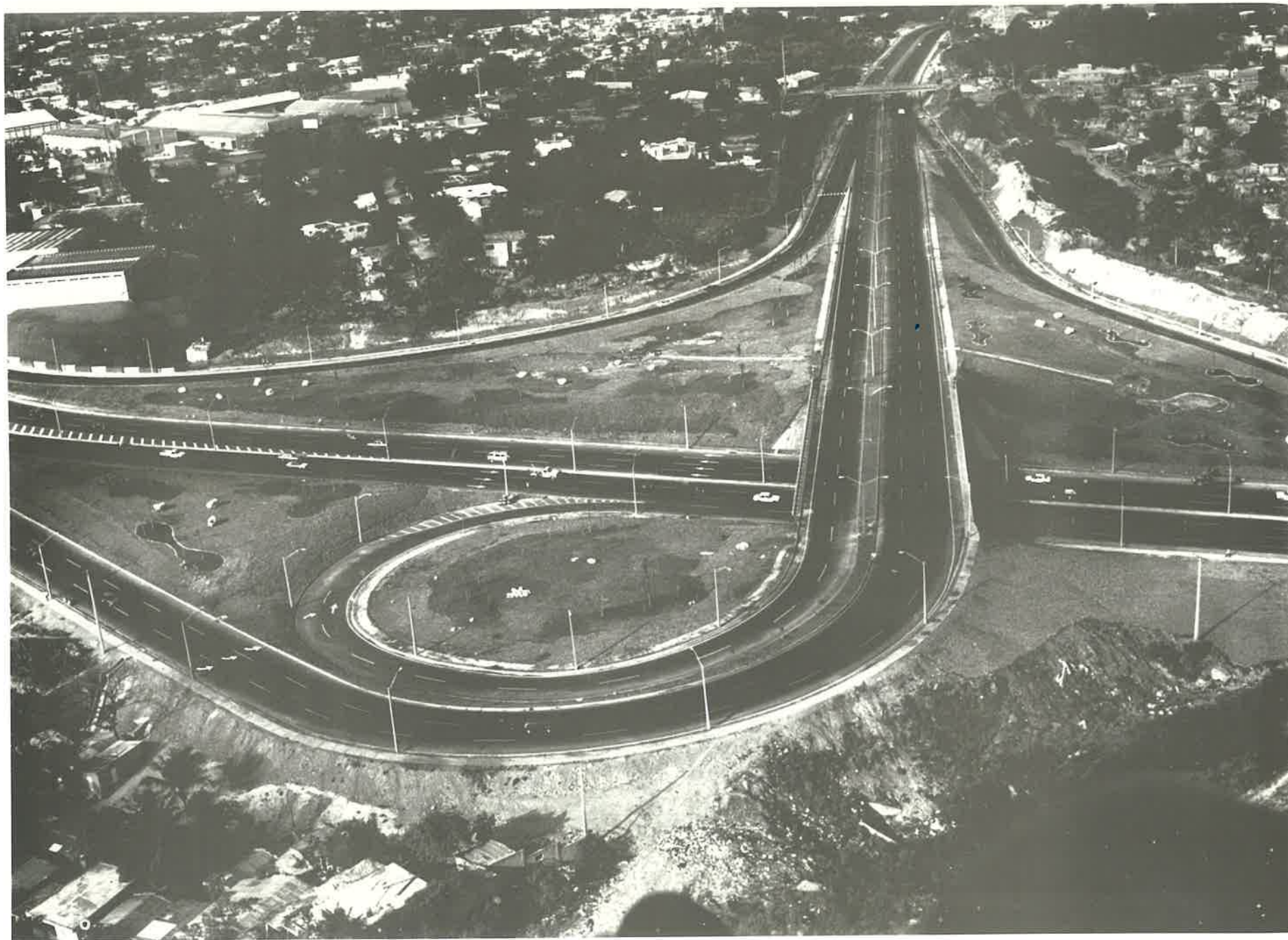
Autopistas del Sur con sus pasos a nivel.
